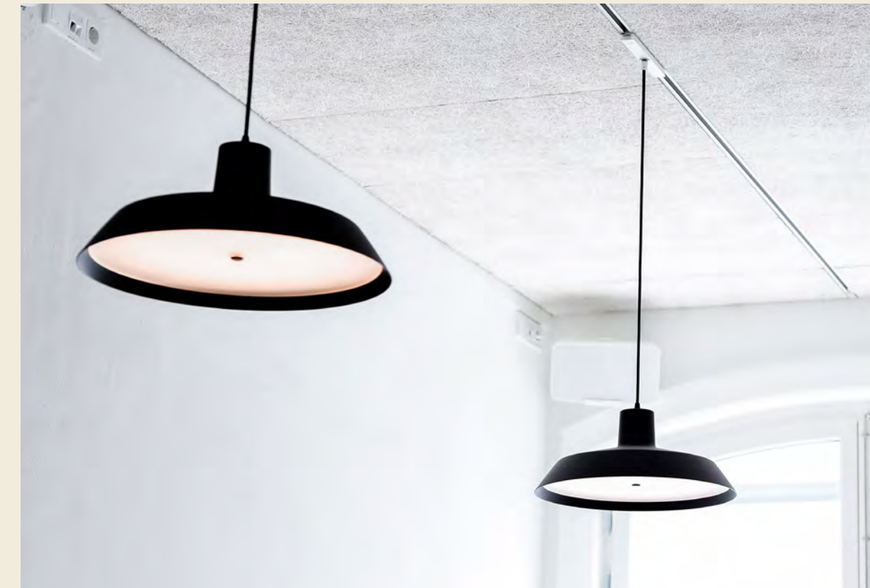
Undertak i träullitplatta
